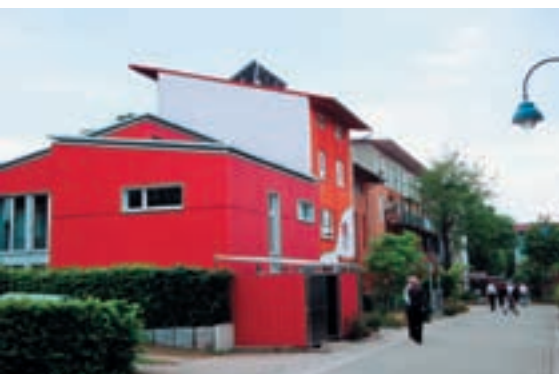
Balade dans l'écoquartier de Vauban, où l'on découvre la grande variété des types de constructions.
